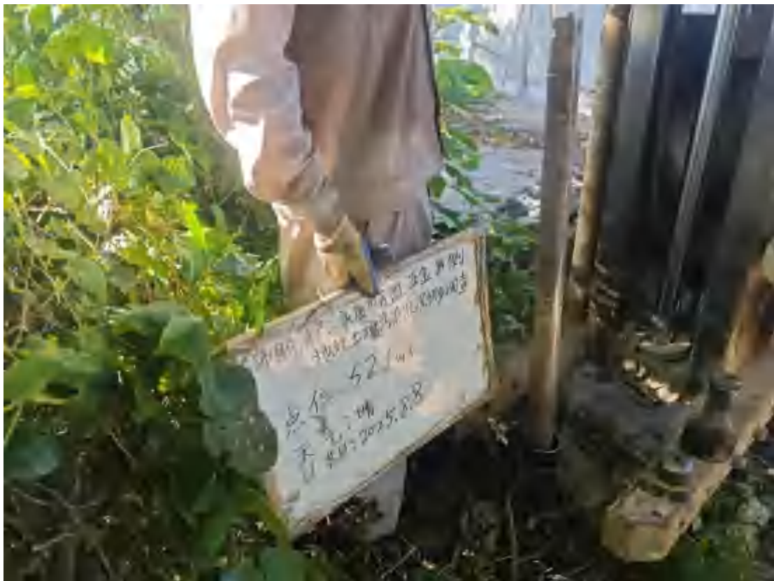
图 5-3 土壤采样钻探现场照片
