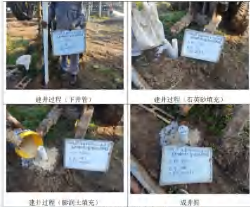
图 8 地下水监测井成井照片
