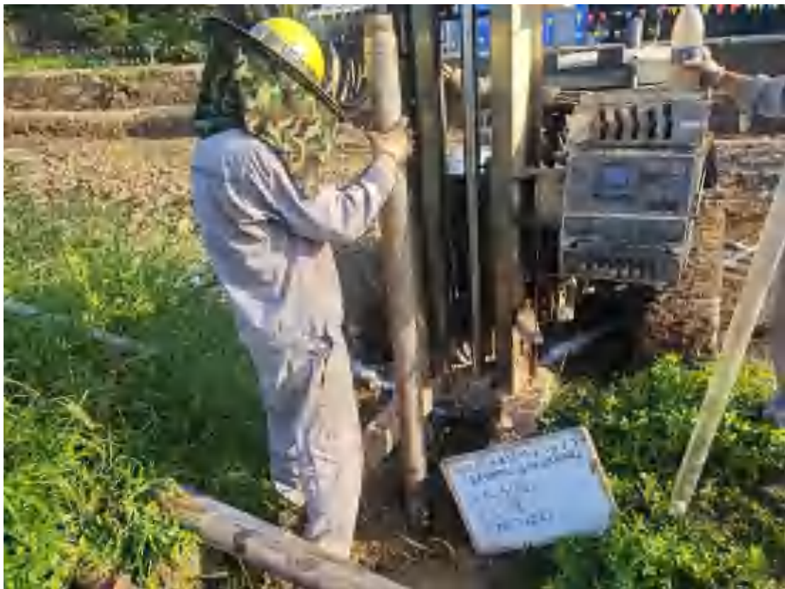
图 5-3 土壤采样钻探现场照片
