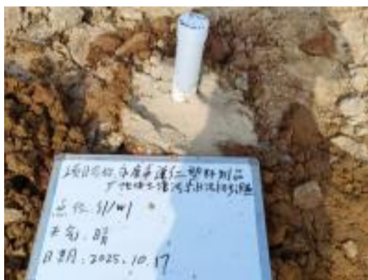
图 5-2 现场成井照片
