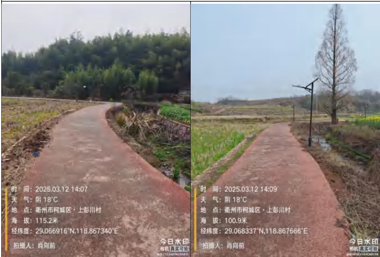
新建防汛道路
