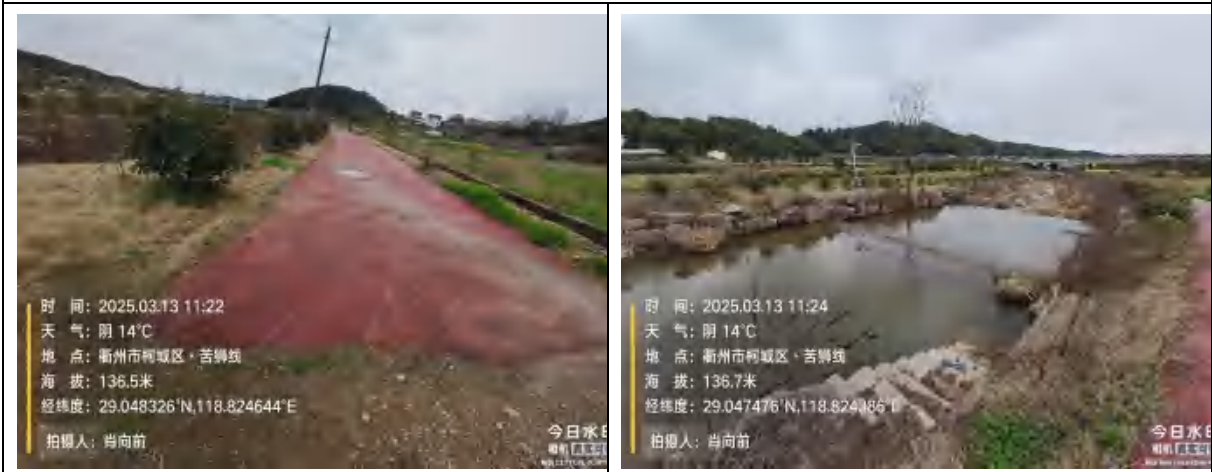
岸顶道路工程
