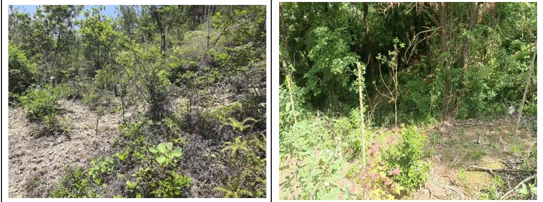
临时施工道路复绿情况（生态红线内）
