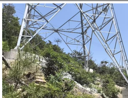
F27 塔基处山地恢复情况（生态红线内）
