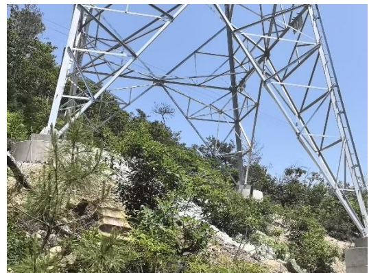
F27 塔基处山地恢复情况（生态红线内）
