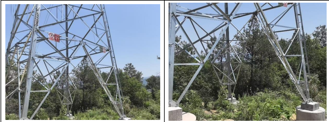
F55 塔基处山地恢复情况（生态红线内）通过采用“高低腿塔基”减少对地形地貌的改变
