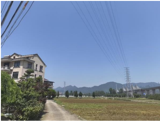
F62 塔基处耕地恢复情况
