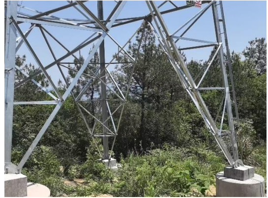
F55 塔基处山地恢复情况（生态红线内）通过采用“高低腿塔基”减少对地形地貌的改变
