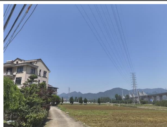
F62 塔基处耕地恢复情况
