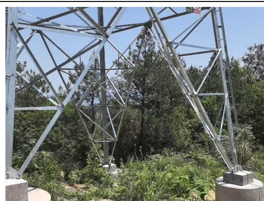
F53 塔基处山地恢复情况（生态红线内）
