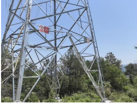
F55 塔基处山地恢复情况（生态红线内）通过采用“高低腿塔基”减少对地形地貌的改变
