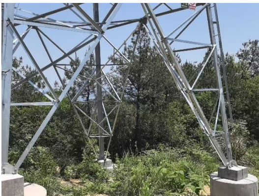
F53 塔基处山地恢复情况（生态红线内）
