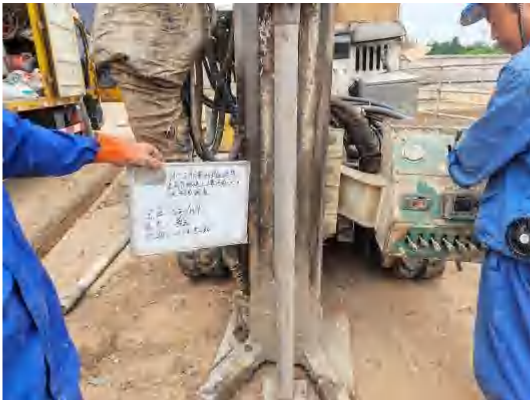
图 5-3 土壤采样钻探现场照片
