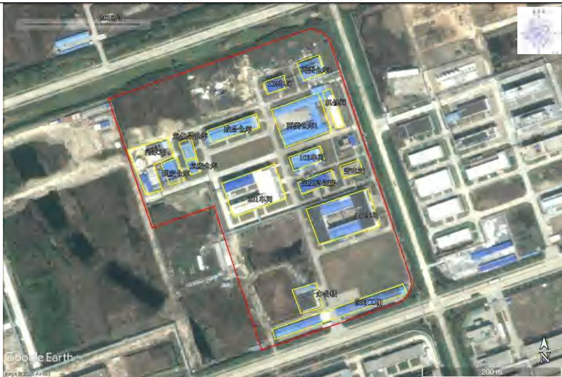
浙江新赛科药业有限公司生产用地，南侧为临时工棚（2009 年污水站进行二次扩建）
