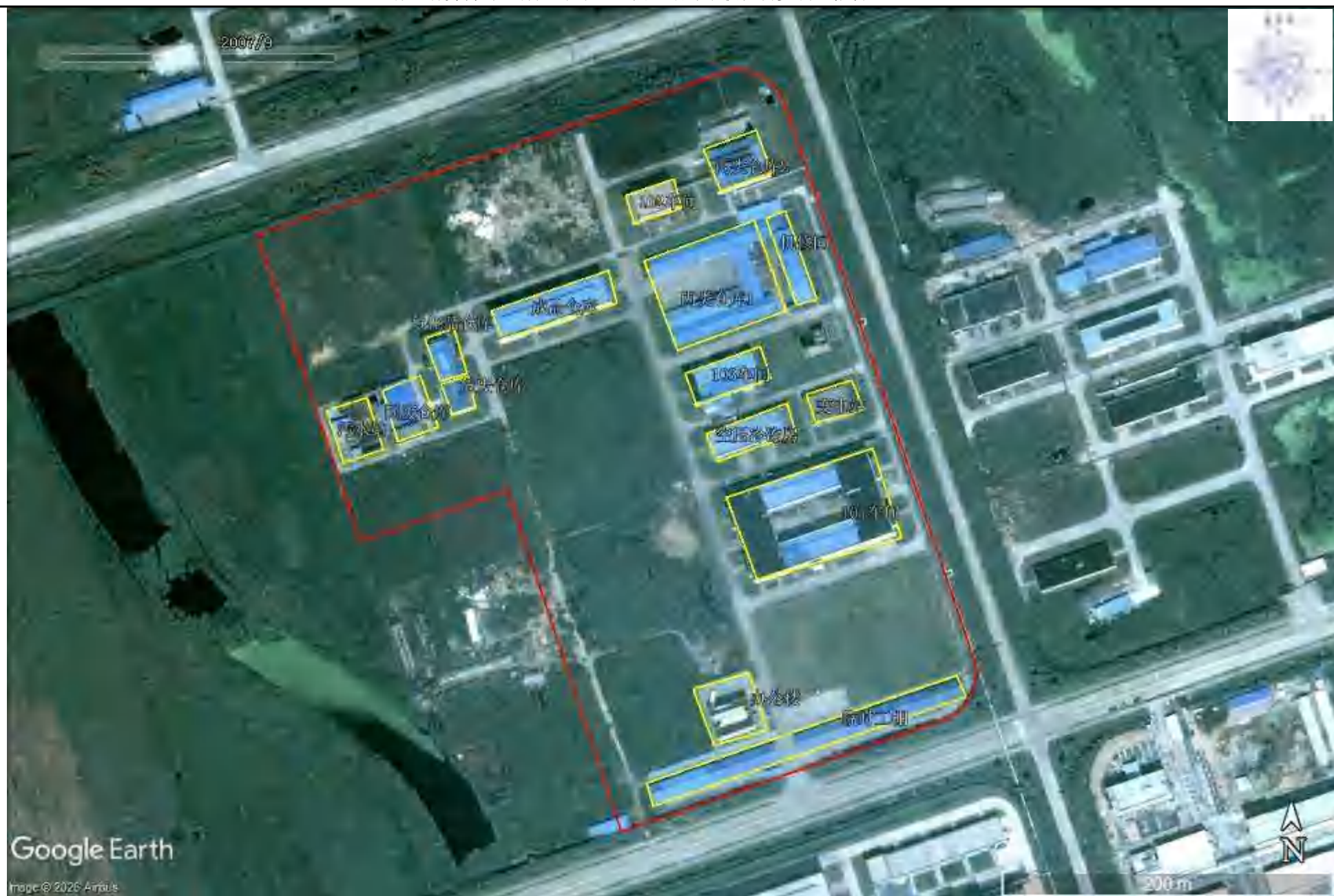
浙江新赛科药业有限公司生产用地，南侧为临时工棚
