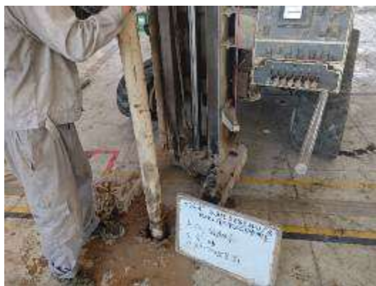
图 5-3 土壤采样钻探现场照片
