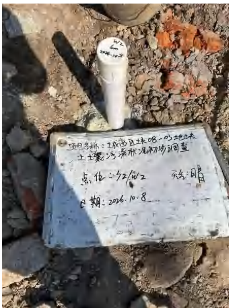
图 5-2 现场成井照片
