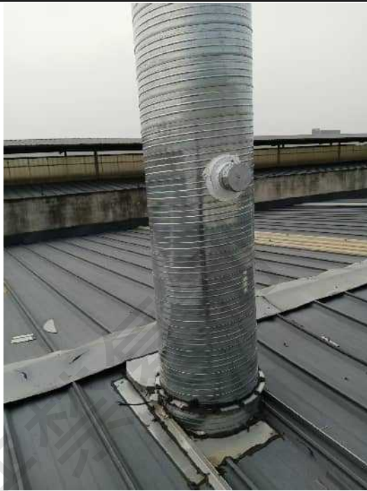
DA005排放口出口采样点位
