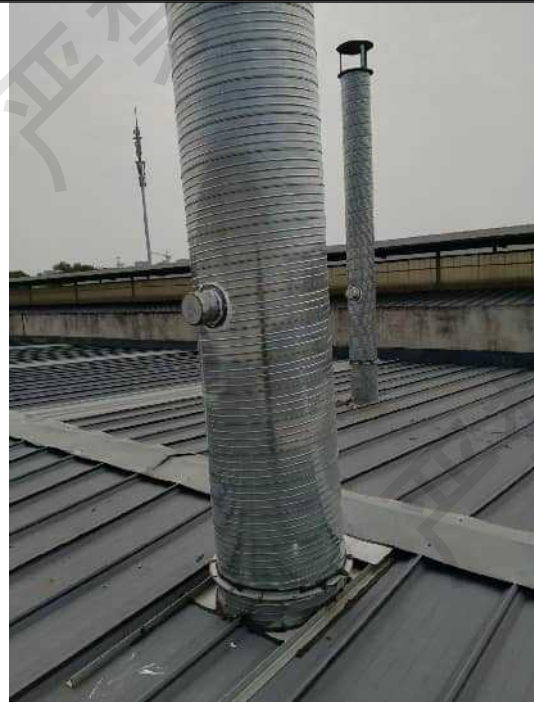
DA004和DA006排放口出口采样点位
