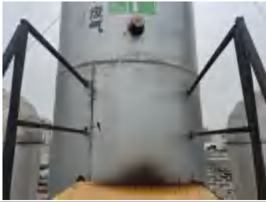
采样监测平台及采样口
