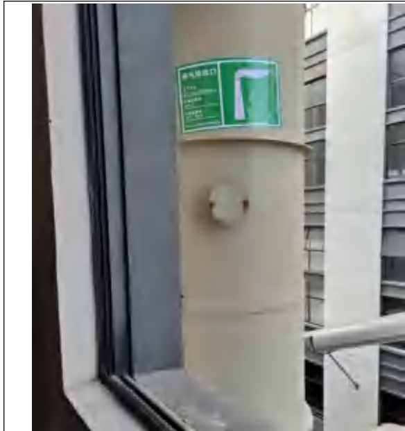
采样监测平台及采样口
