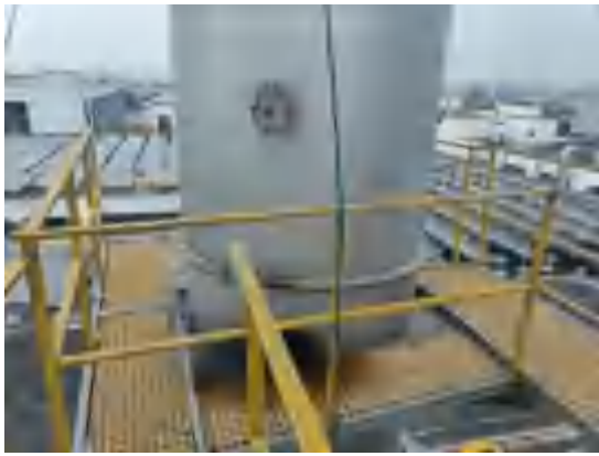
采样监测平台及采样口
