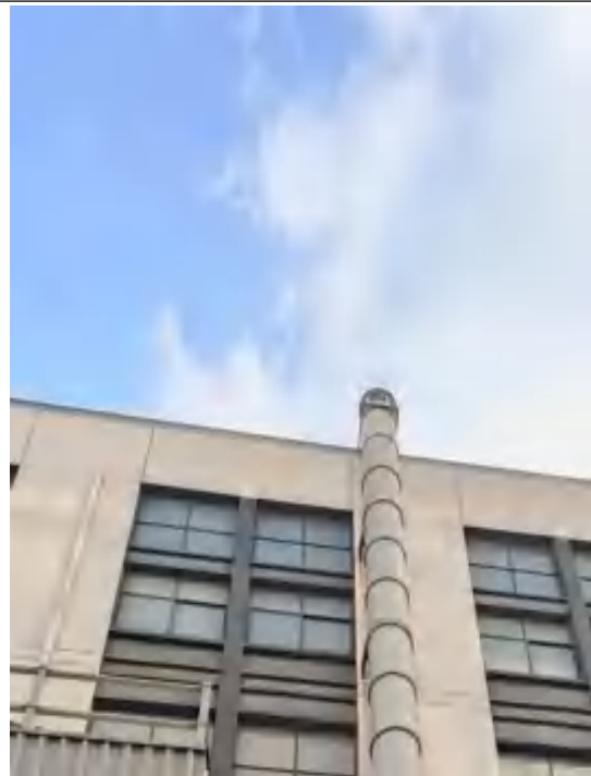
DA009污水站废气排放口1
