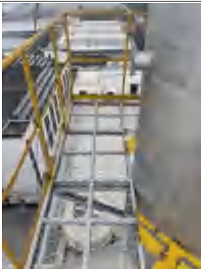
采样监测平台及采样口
