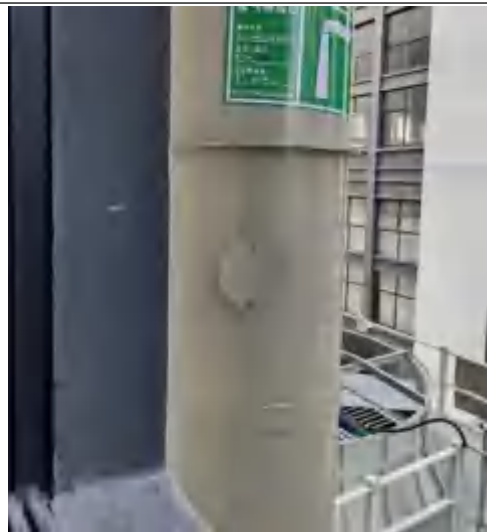
采样监测平台及采样口
