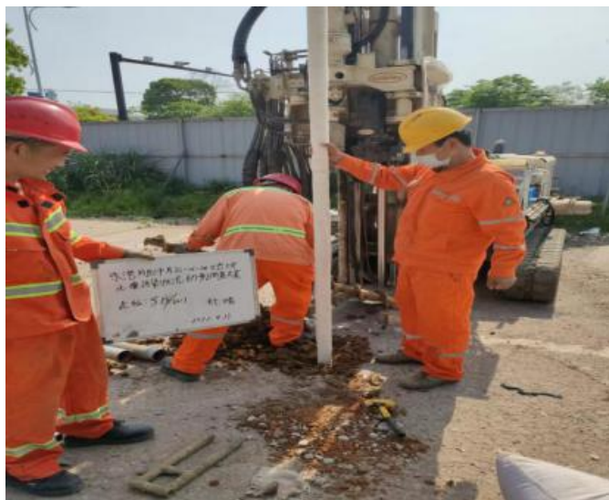
图 5-2 现场建井照片
