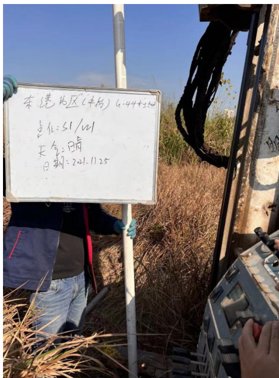
图 5-2 现场建井照片
