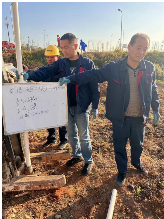
图 5-2 现场建井照片
