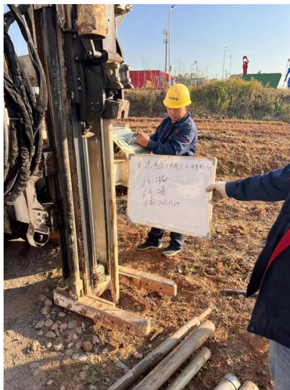
图 5-3 土壤采样钻探现场照片
